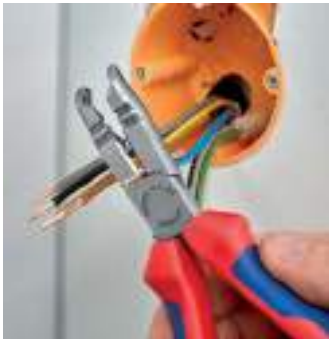
Realizar cortes al acortar conductores individuales
