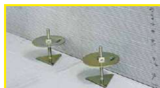
1º Posicionar niveladores.
