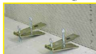
1º Posicionar niveladores.
